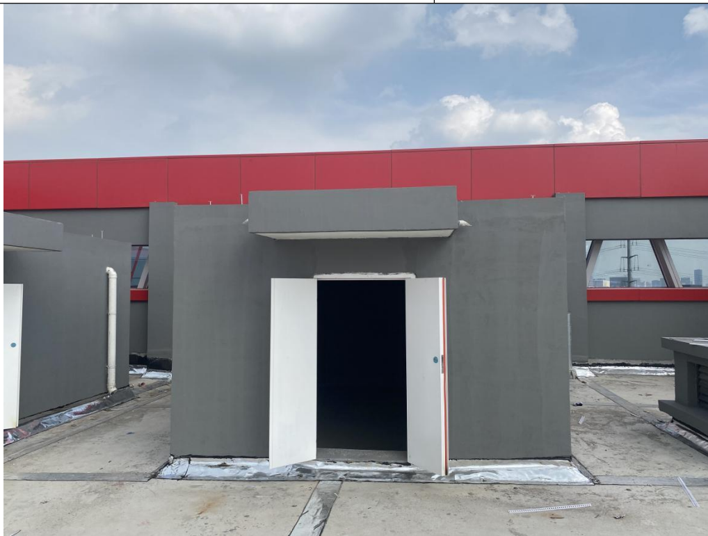
楼顶废气排放口预留位置
