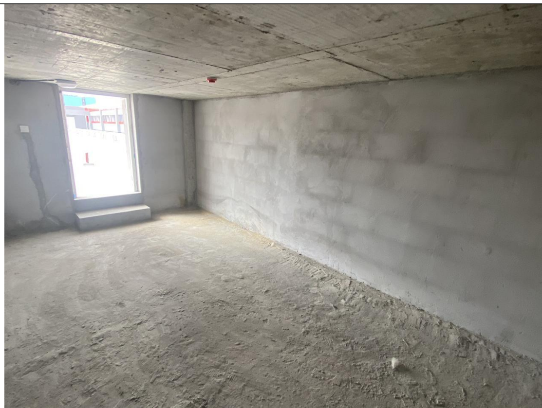
预留废气处理设施安装位置
