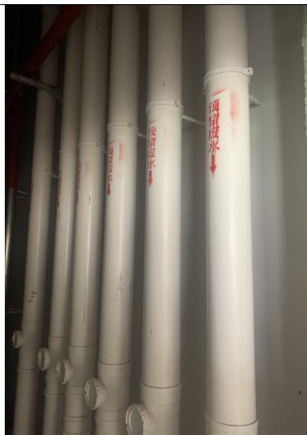
预留污水管道
